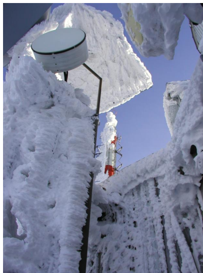
1,2 m Antenne mit De-Icing-System
